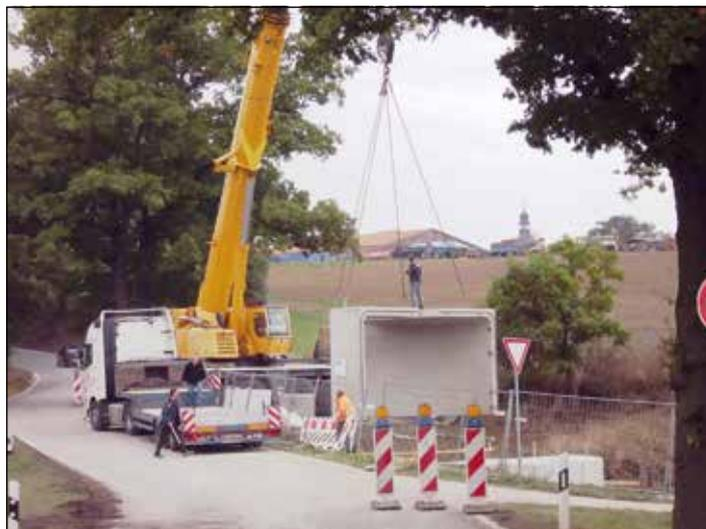
Ein wichtiger Tag beim Bau der Kläranlage Leubnitz. Am 11.10.2016 wurden große Betonteile mit Spezialtransportern angeliefert und mit einem Mobilkran in die Baustelle gehoben. Sogar eine halbseitige Sperrung der Landstraße war unweit des Sägewerkes Weißmühle nötig. Die Baumaßnahme hing im wahrsten Sinne des Wortes am Haken.
