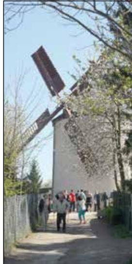
Bei ständig sich ändernden Windverhältnissen war es zum ersten Flügeldrehen der Windmühle in diesem Jahr sehr schwierig, durch das rasche Ändern der Lamellen in den Ruten des Flügelkranzes den Betrieb des technischen Denkmals vorführbar zu halten. Foto: jpk
